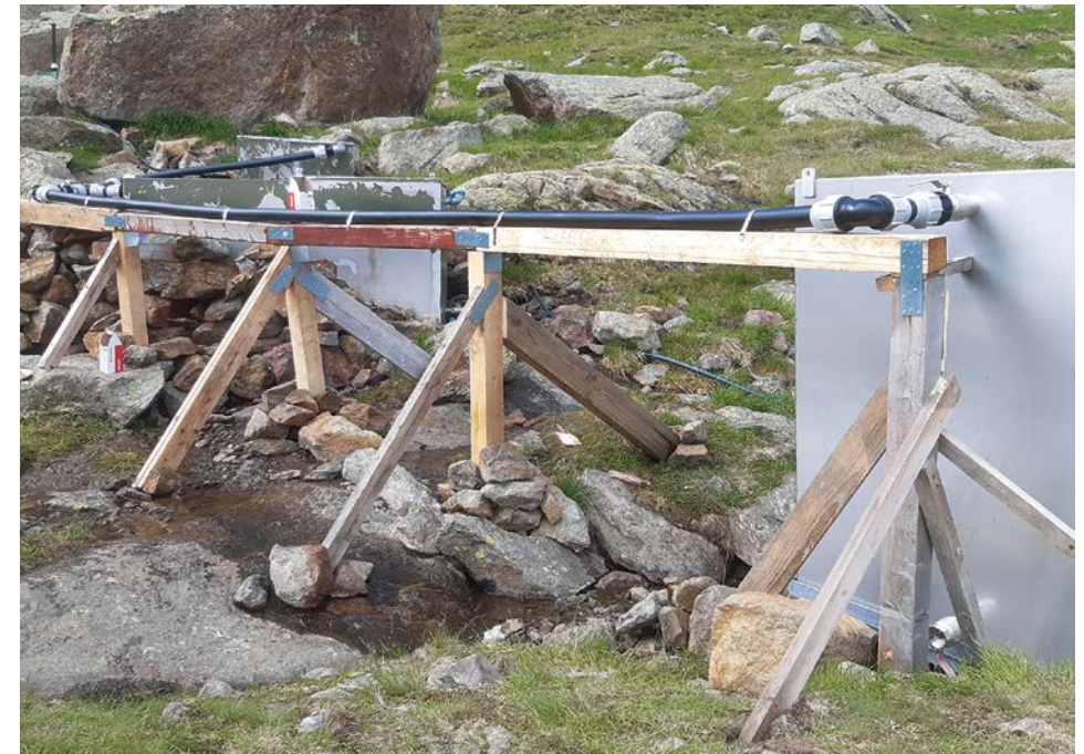
Neue stärkere Abstützung der Wasserleitung
